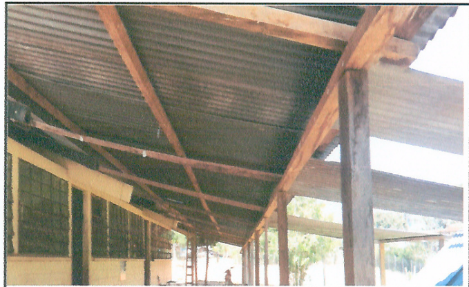
Foto 2: Cambio cubierta de lamina patio
