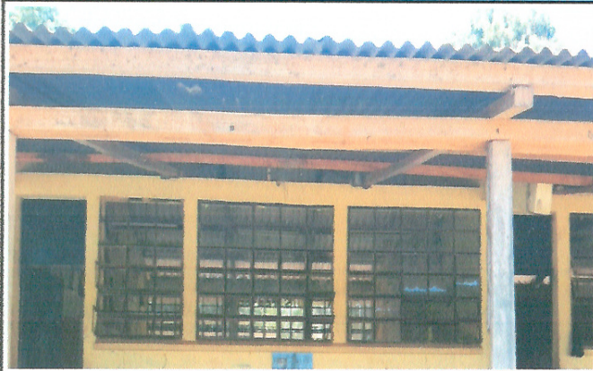
Foto 1: Mejoramiento de estructura de techo
