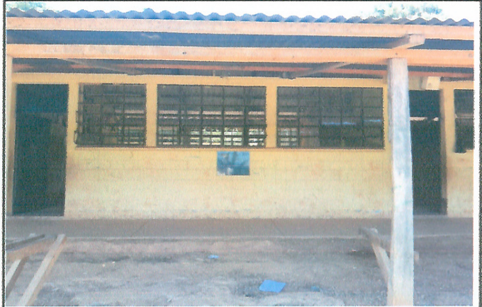
Foto 4: Patio frontal mejorara con losa de piso
