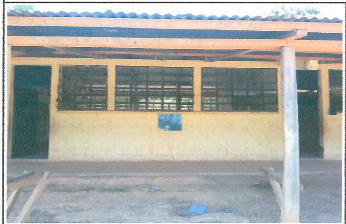
Foto 4: Mejoramiento cubierta de lamina patio
