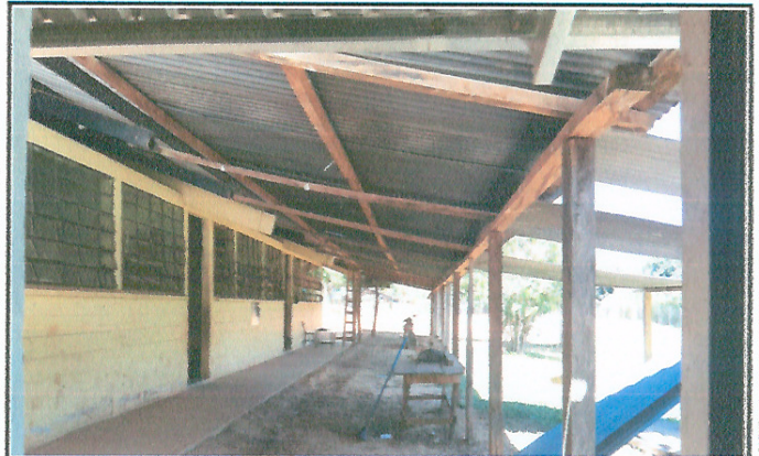
Foto 2: Cambio de estructura de madera a metal
