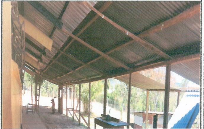
Foto 4: Mejoramiento estructura de techo del patio
