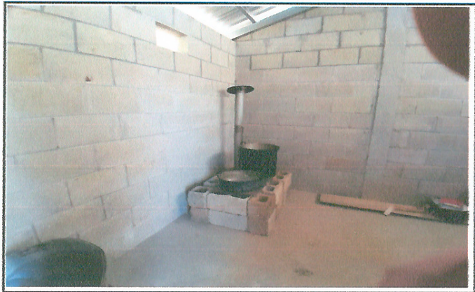
Foto 2: Sustitución de Estufa rural, plancha y su chimenea
