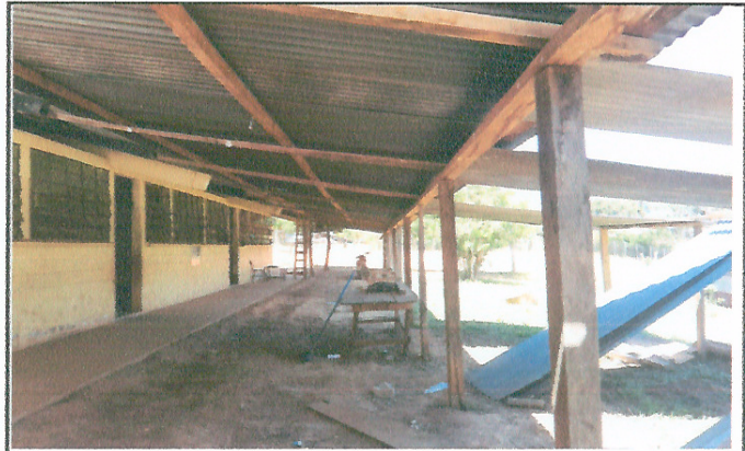
Foto 2: Aplicar losa de piso al patio
