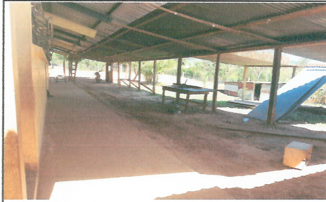
Foto 1: Mejoramiento de patio (aplanar)
