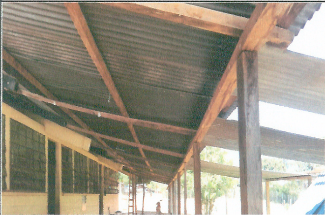
Foto 3: Mejoramiento estructura de techo del patio
