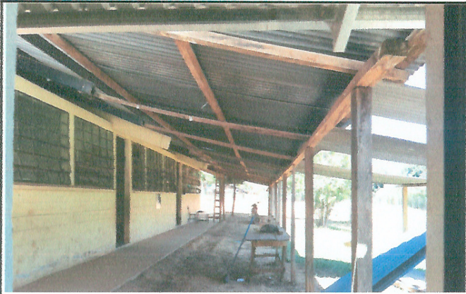
Foto 1: Cambio cubierta de lamina
